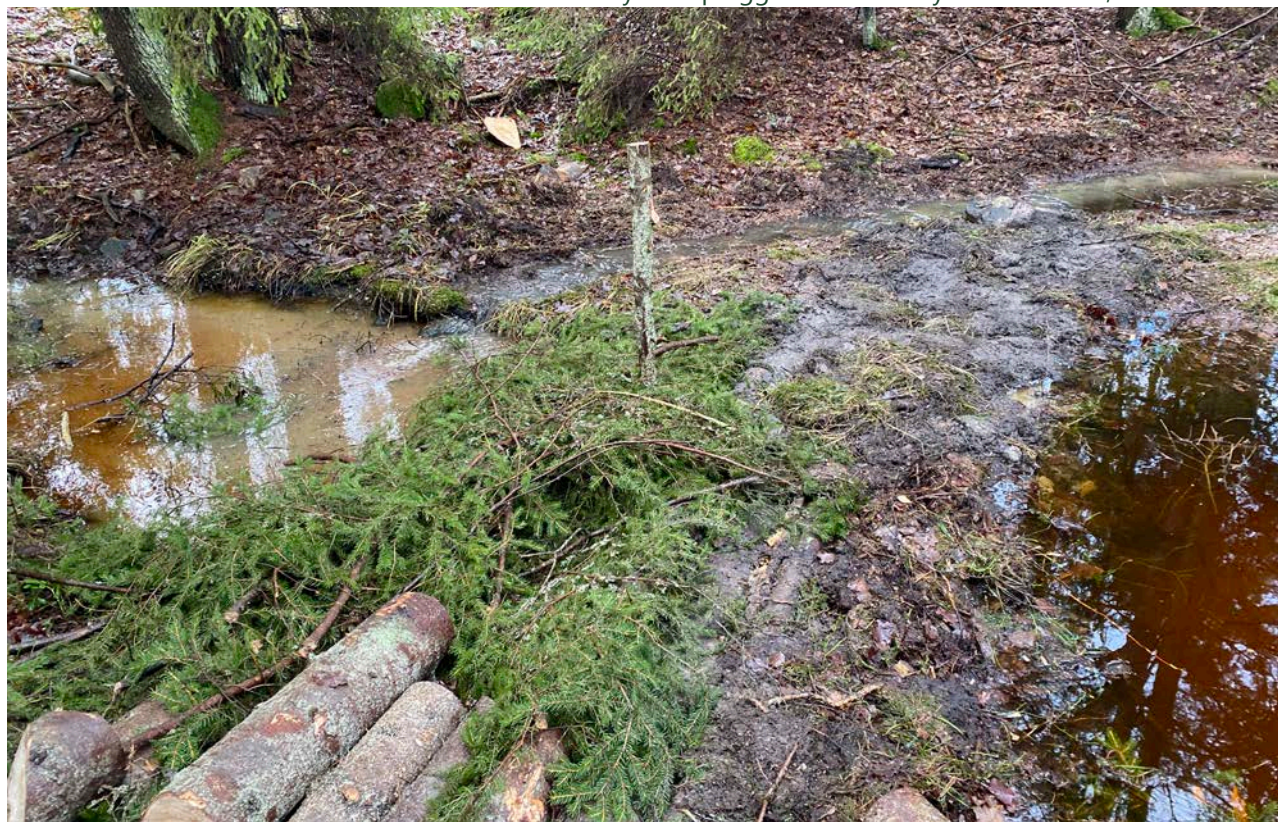
Plywoodplugg i dike under fyllmassor. Foto, Sören Eriksson
